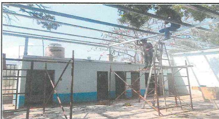
Foto 3: Avance de sustitución de galera de lámina y madera
