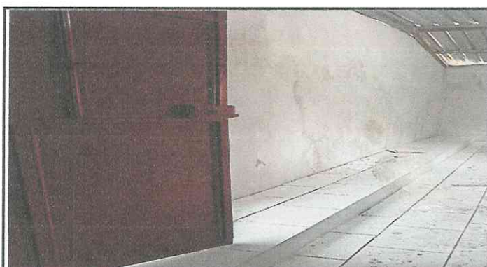
Foto 4: Avance de Repello de área 3 de cocina, avance de sustitución de torta de piso deteriorado por piso cerámico y avance de mantenimiento de puerta.
