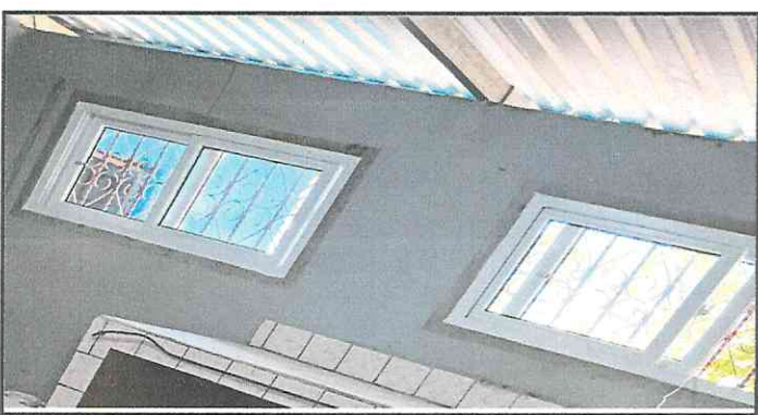
Foto 6: Avance de Sustitución de ventanas y mantenimiento de balcones
